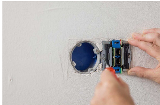
Fixez avec les vis d'installation du boîtier d'encastrement utilisé.
