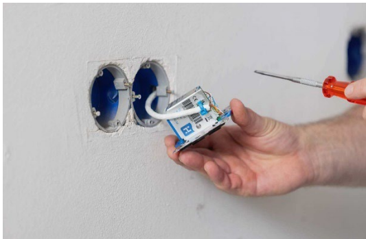
Montage de l'APAC W dans le mur
